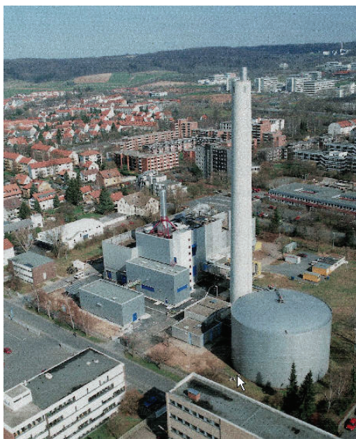
Bild 1: Das Heizkraftwerk der Universität Göttingen
